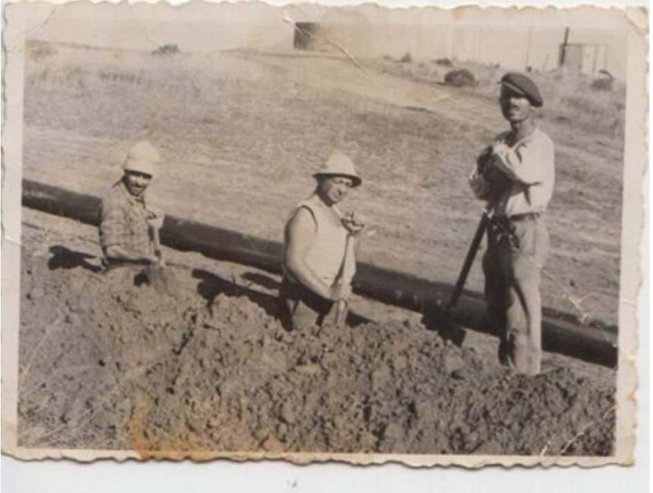
Instalasyon de un tubo de agua; mi padre a la syedra
